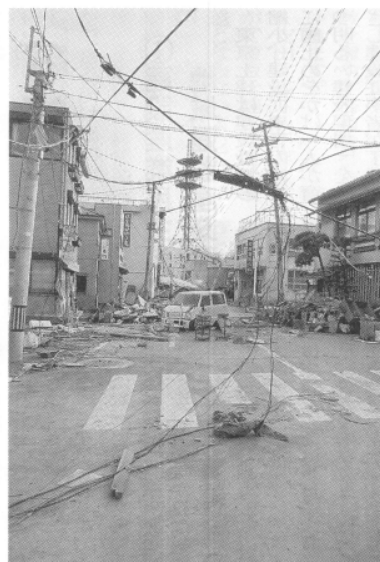
被災地の被害は甚大(写真は石巻市)
